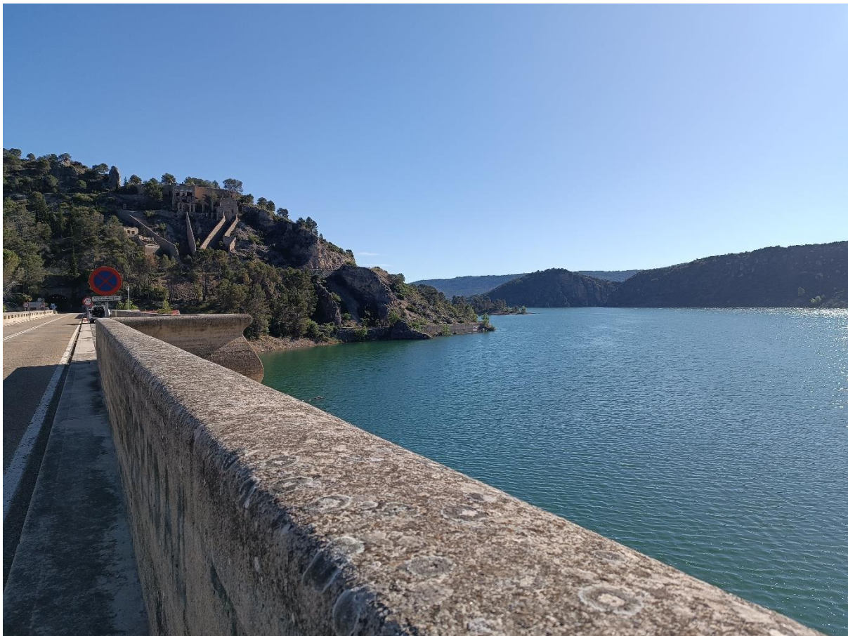
Přehrada na Rio Tajo
