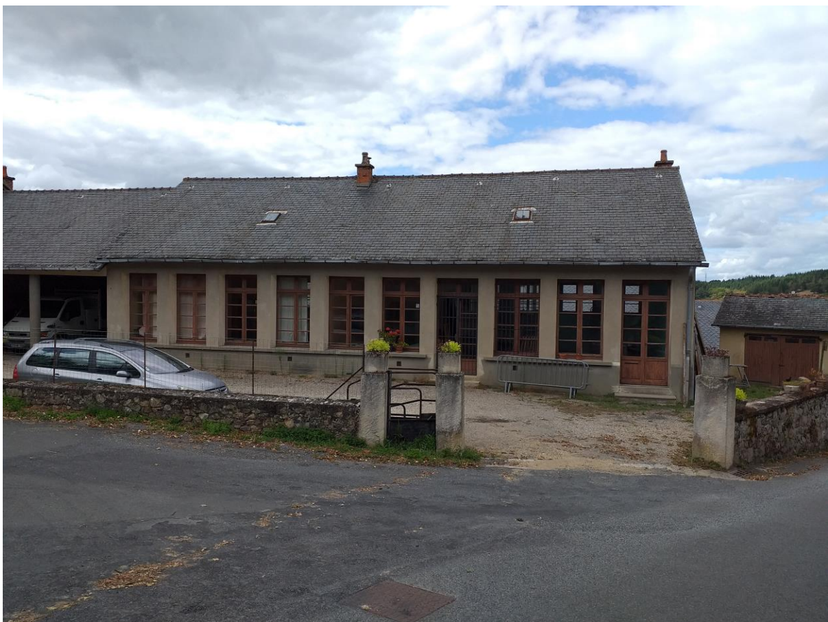
Bývalá škola a poutníkův dnešní nocleh.
